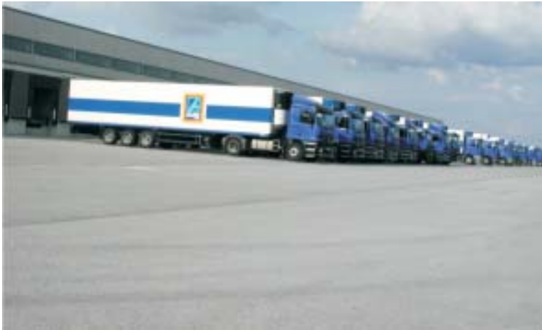
Lkw-Schleusen und Rangierfläche am neuen ALDI-Standort
