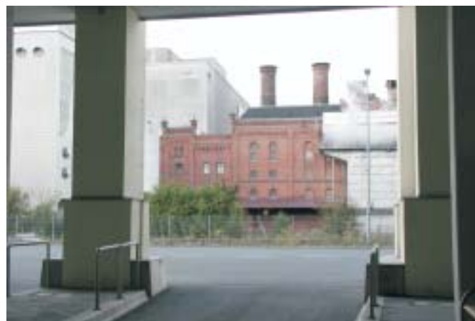
Blick durch die 2. Busbahnhofausfahrt auf einen ebenfalls denkmalgeschützten Fabrikbau (Unima-Malzfabrik, 1896), der in den neuen Gebäudekomplex integriert worden ist.
