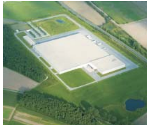
Das neue ALDI-Lager von oben
