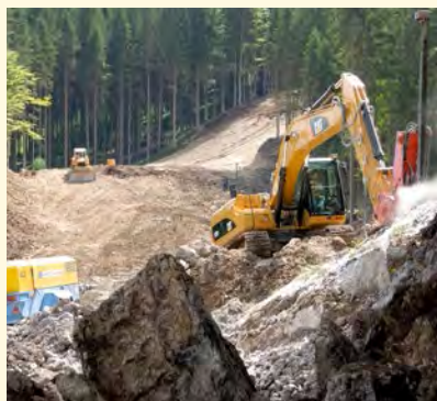
BU: Baumaßnahmen an der Kandahar-Abfahrt in Garmisch-Partenkirchen für die Ski-WM 2011
