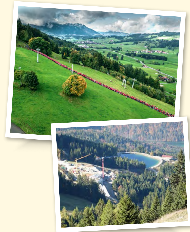
Ausbau der Jennerbahn im Berchtesgadener Land
